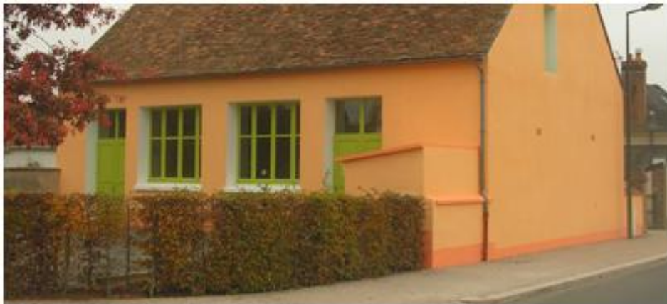
La cantine scolaire
